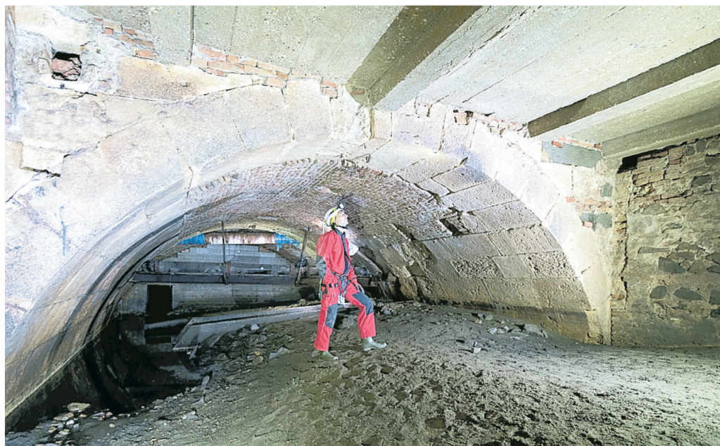
Il ponte romano San Daniele, il terzo di via Umberto I, una ricercatrice e il tombino che dà accesso al manufatto
